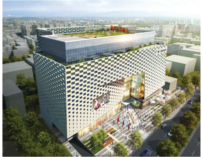
인천동 M프로젝터 신축공사 중 철골공사 (2015, 대구) ·업종 | 쇼핑센터 ·면적 | 69,660m 2
