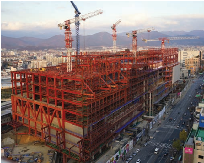
동대구역 복합센터 현장 중 철골공사 (2014, 대구) · 업종 | 쇼핑센터 · 면적 | 24,111m 2
