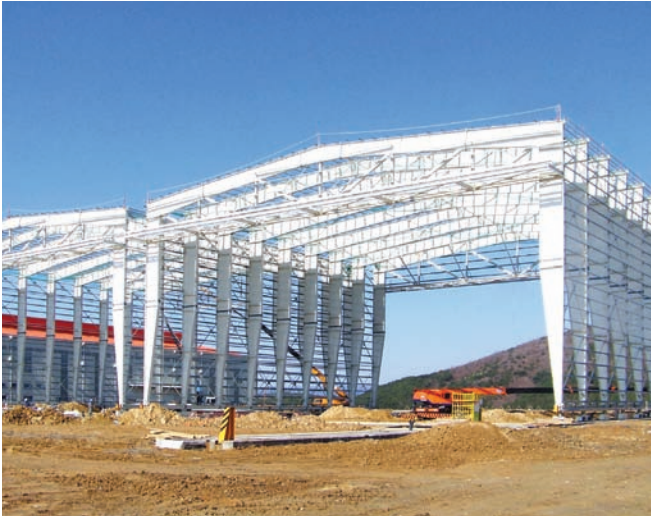
엔케이 포항공장 무빙셸터 건설공사 (2009, 포항) ·업종 | 제조업 ·면적 | 1,840m 2
