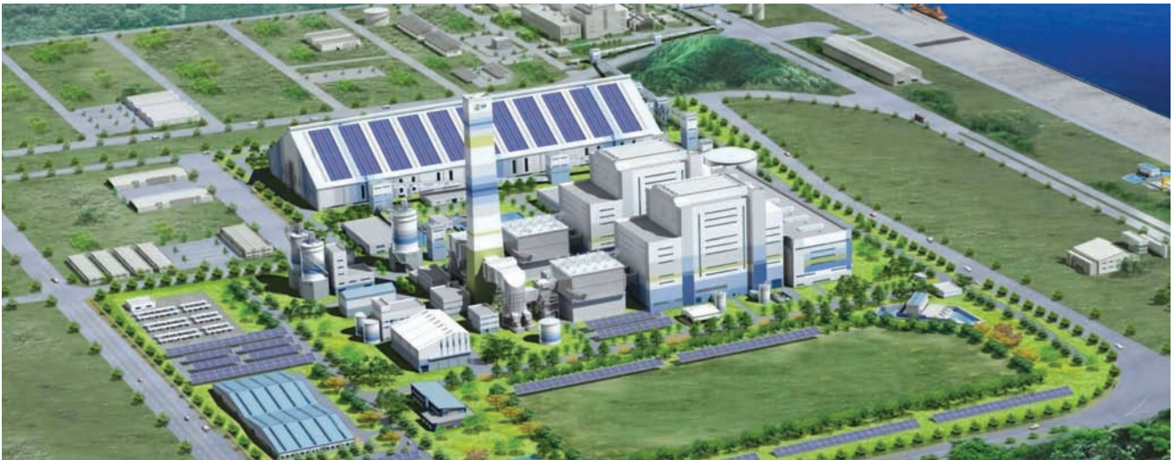
북평화력 1, 2호기용 석탄취급설비 설치공사 중 PEB 철골공사 (2014, 강원) · 업종 | 발전소 · 면적 | 30,192m 2
