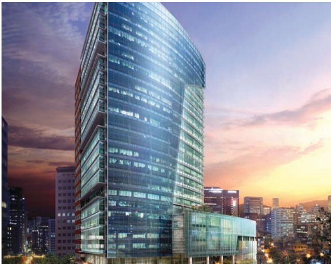
중구 쌍림동 도시환경정비사업 철골공사 (2008, 서울) ·업종 | 업무시설 ·면적 | 19,747m 2
