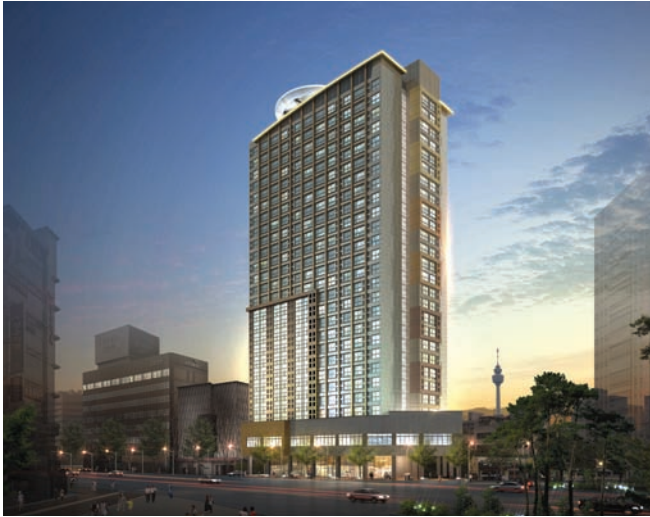
대구 두류동 아이작큐브 오피스텔 신축공사 중 철골공사 (2016, 대구) ·업종 | 숙박시설 ·면적 | 1,537m 2
