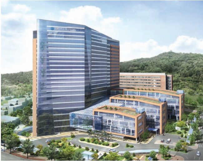
계명대학교 동산의료원 새 병원 신축공사 중 철골공사 (2013, 대구) · 업종 | 의료시설 · 면적 | 13,816m 2
