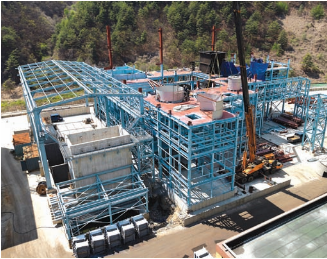
영풍 석포제련소 철골공사 (2008, 봉화) · 업종 | 제조업 · 면적 | 4,680m 2
