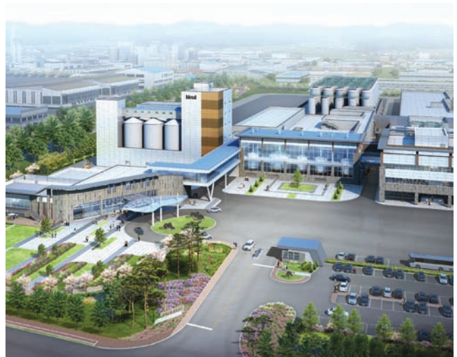
롯데칠성 맥주 2공장 신축공사 중 PEB 철골공사 (2015, 충북 충주) · 업종 | 제조업 · 면적 | 33,832m 2
